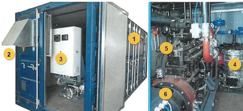
4. ábra A konténer (1), a légbeszívó (2), a vezérlő elektronika szekrény(3), a szigetelt gázgenerátor(4), a gázmotor(5) és a villamos generátor(6)
